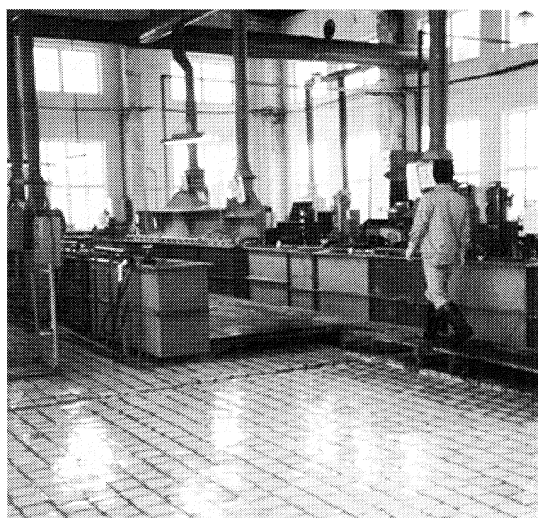
▲ めっき工場の据付1.
